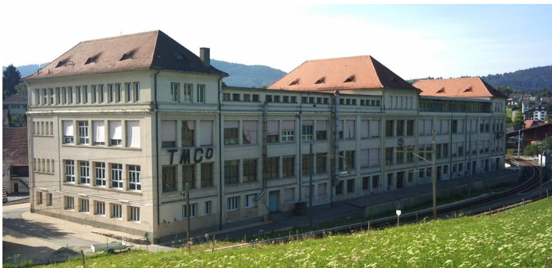
Fig.4 : Vue de la face est du bâtiment « Tavannes Machines »
