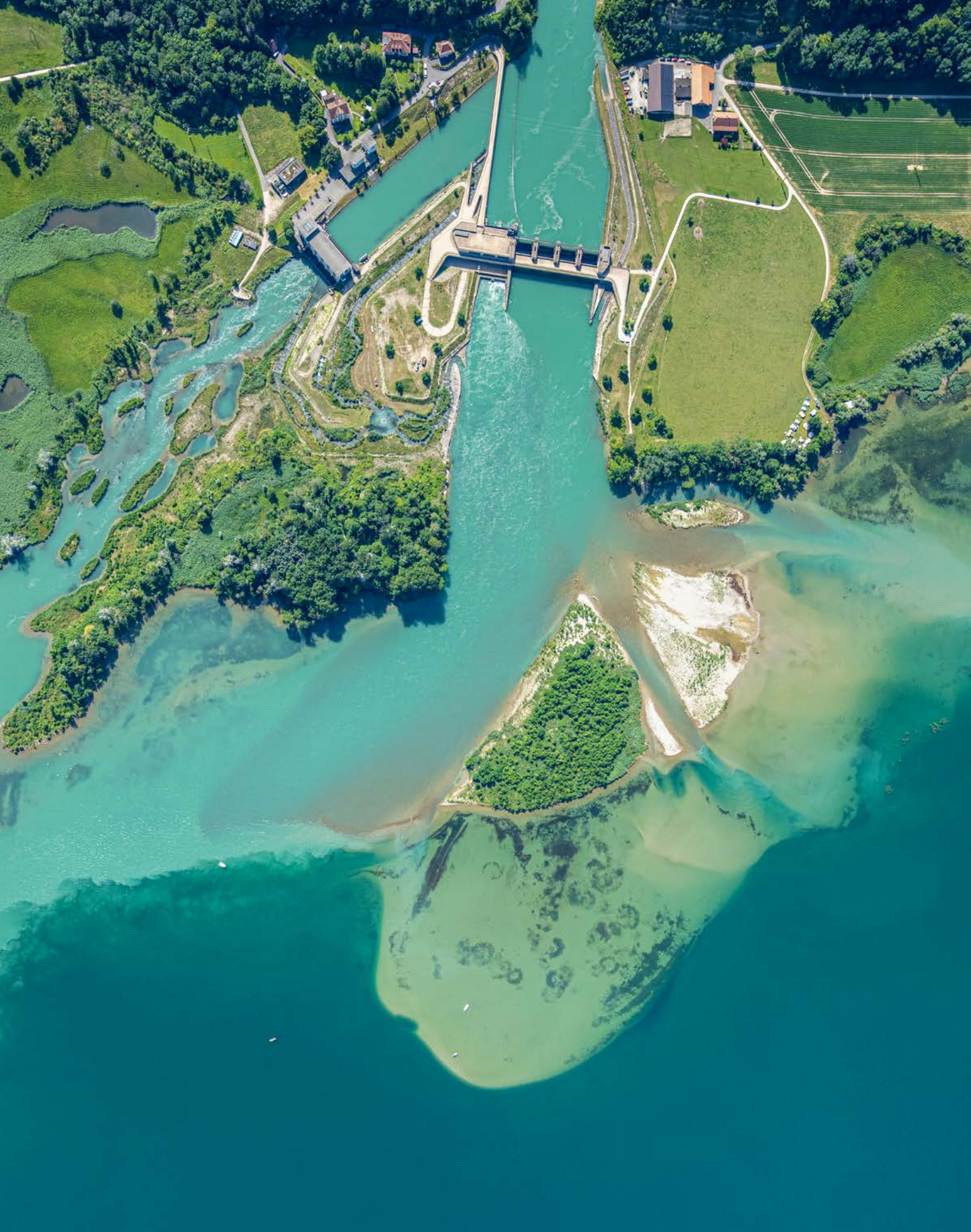
À l'embouchure du canal de Hagneck dans le lac de Bièvre, l'utilisation de la force hydraulique, la protection des zones alluviales, la pratique d'activités de loisirs et l'exploitation agricole se côtoient. © DEEE-OAN.
