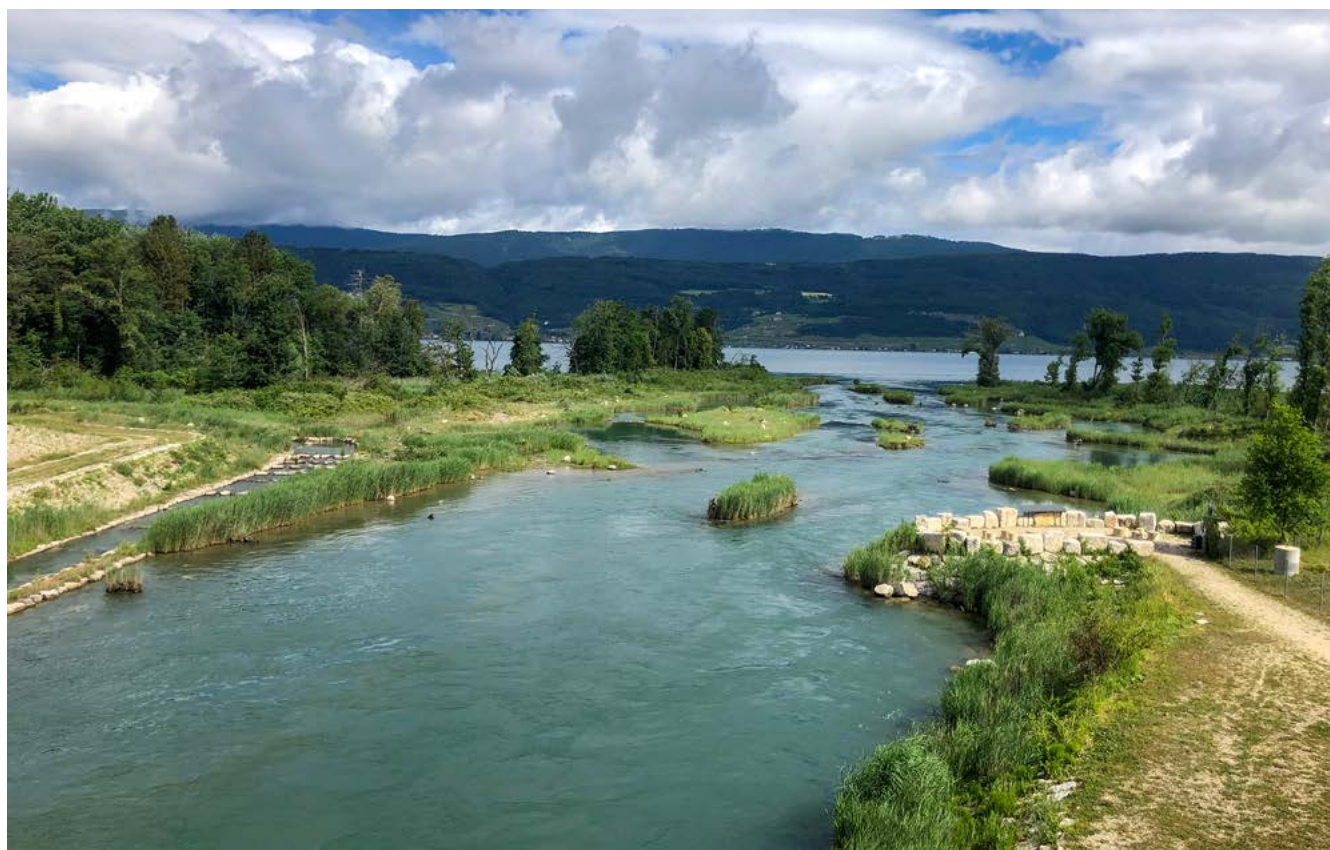
La centrale hydroélectrique de Hagneck est située dans une zone alluviale protégée ainsi que dans une réserve d'oiseaux d'eau et de migrateurs d'importance nationale. Lors de la rénovation, une grande attention a été portée à la renaturation. Le canal de contournement pour les poissons (à gauche) est unique en son genre en Suisse. © DEEE-OAN.
