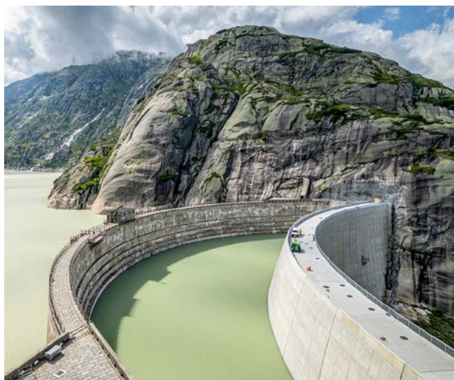
Le barrage de Spitallamm, sur le lac du Grimsel, est essentiel pour la production d'électricité dans le canton de Berne. Construit il y a plus de 90 ans, l'ouvrage est réhabilité depuis 2019 par KWO, qui a achevé la construction du nouveau mur en 2025. L'eau du lac pourra ainsi être utilisée à long terme, sans restriction, pour produire du courant. © KWO / David Birri.
