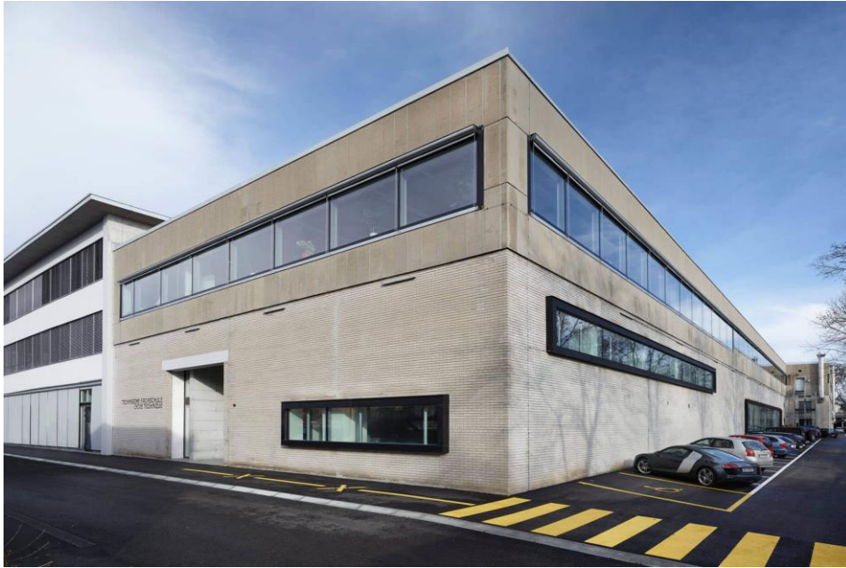
III. 2 : Vue extérieure du site de la rue de la Gabelle 18 à Bienne.
