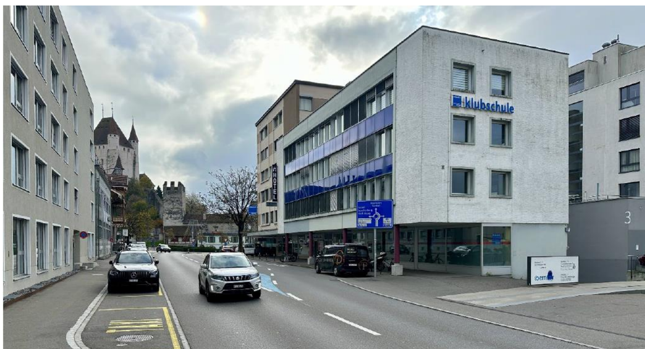
III. 2 : Vue extérieure du site de la Bernstrasse 1A à Thoune
