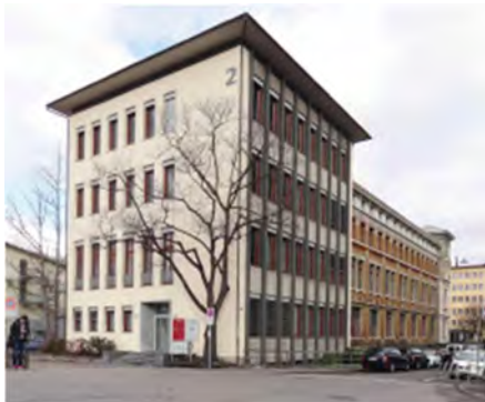
Abb. 2: Ansicht Fabrikstrasse 2 von Süden (Quelle: Bauinventar der Stadt Bern)
