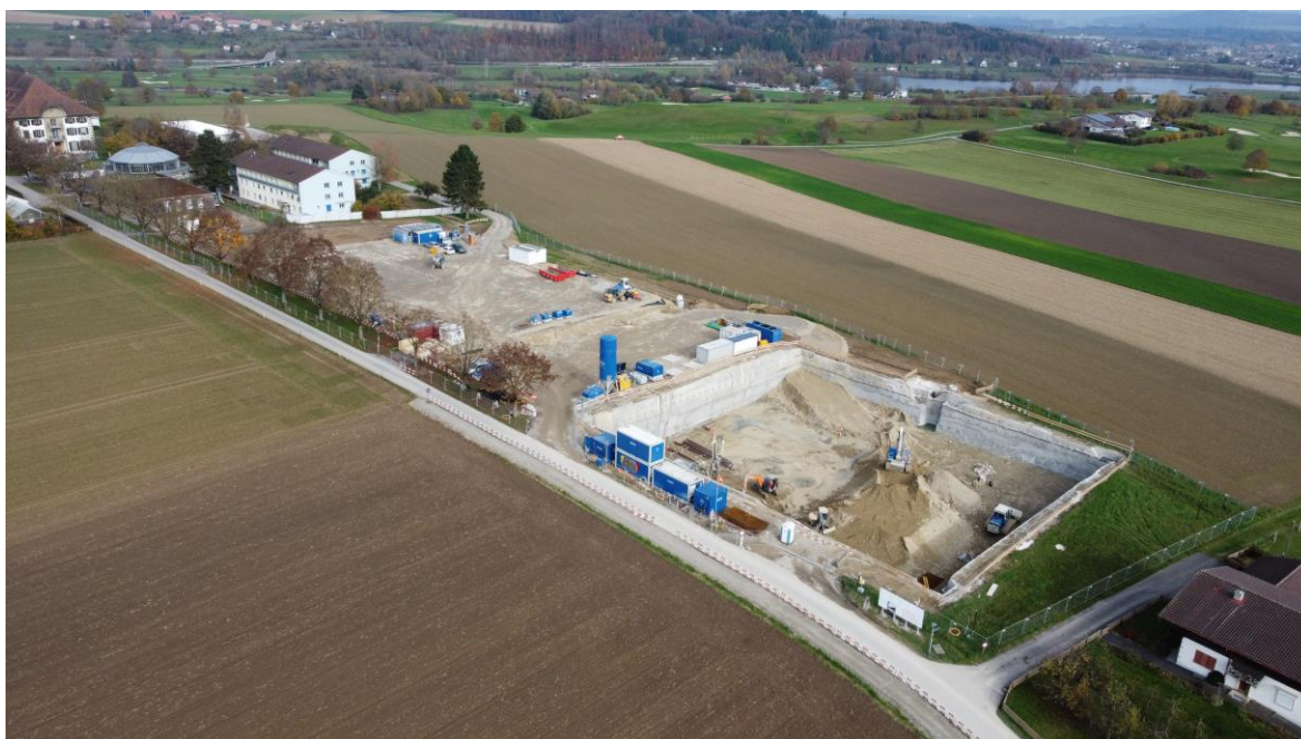
Abbildung 1: Bauplatz neue Sporthalle / neuer Schulbau, Stand Mitte November 2024
