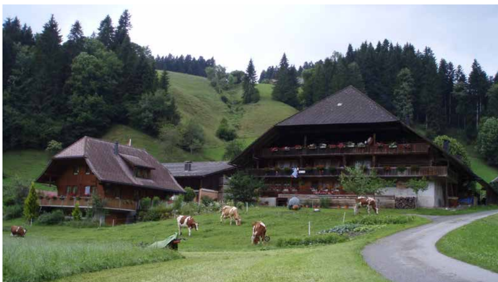
Fig. 3 Le respect des exigences en matière de protection des eaux doit également être garanti dans les exploitations agricoles.
