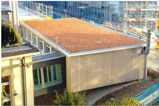
III. 2 : Le pavillon actuel et la passerelle le reliant au bâtiment principal
