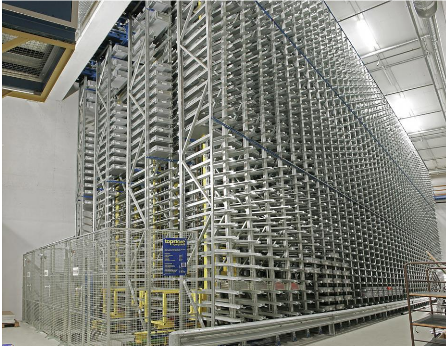
Abb. 1: Vorhandenes Behälterlager an der Brünnenstrasse 66.
