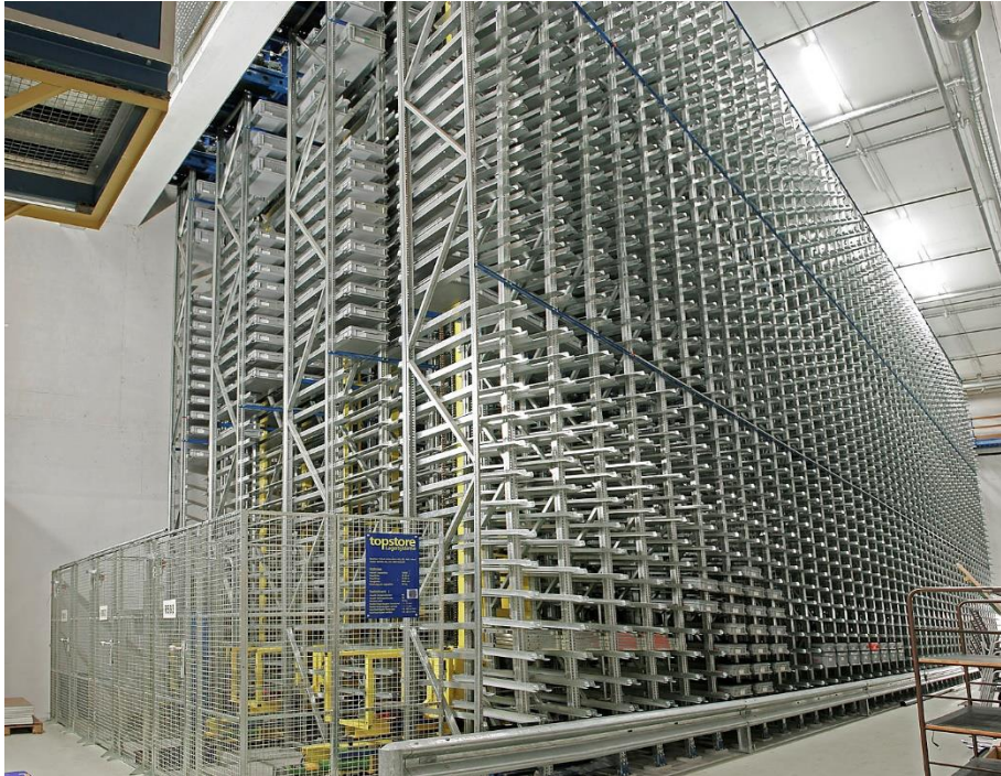
Illustration 1 : Entrepôt à caisses actuel de la Brünnerstrasse 66.
