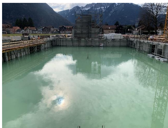
Abbildung 2: geflutete Bodenplatte
