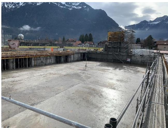
Abbildung 1: abgehobene Bodenplatte
