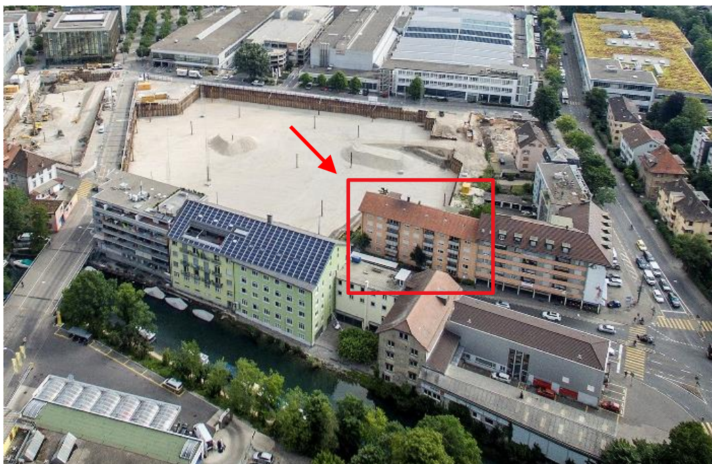
Abb.: 1 aktuelle Flugbildaufnahme Baubereich Campus Biel/Bienne
