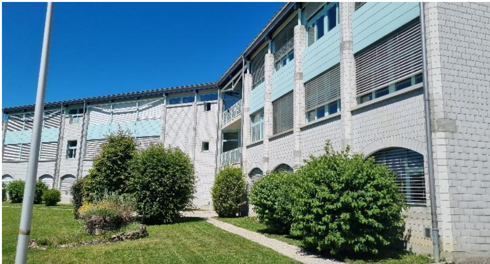
Abb. 2: Ansicht Gebäude Beau-Site 9
