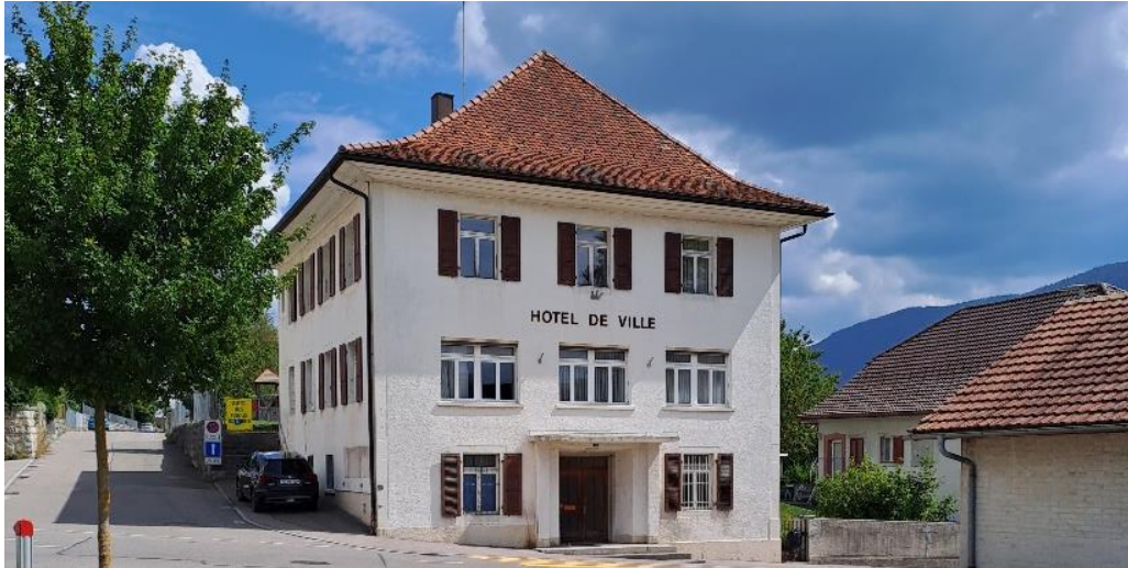
Abb. 4: Ansicht Gebäude Rue de Dr. Tièche 20
