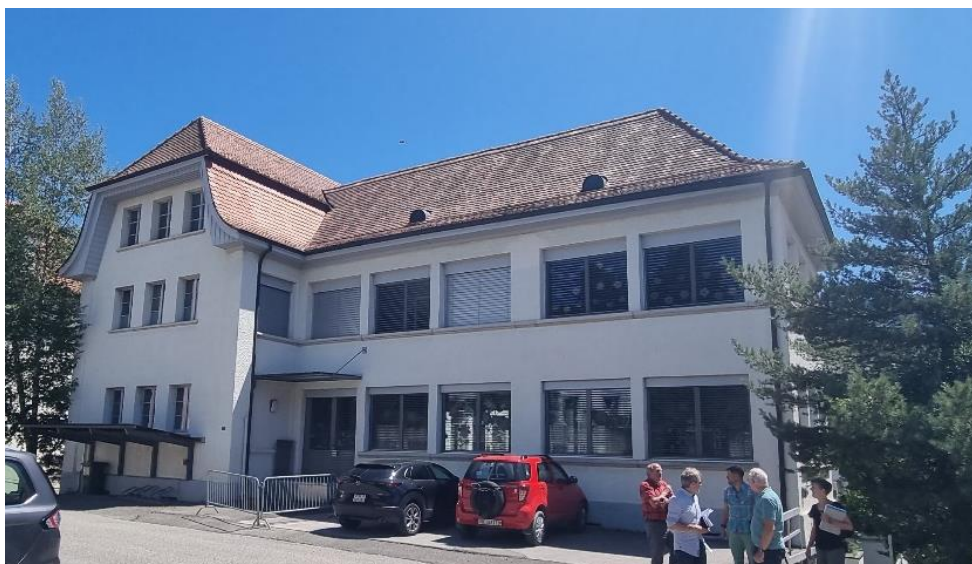
Abb. 3: Ansicht Gebäude Rue de Bel-Air 20 in Reconvilier.
