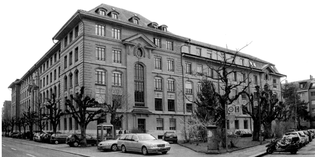
Ansicht Nord-West der Liegenschaft Mittelstrasse 43, Länggasse, Bern
