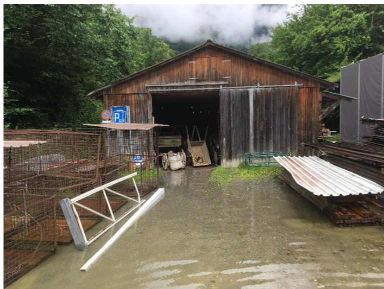
Dépôt dans la zone du hangar lors des fortes pluies de juillet 2021
