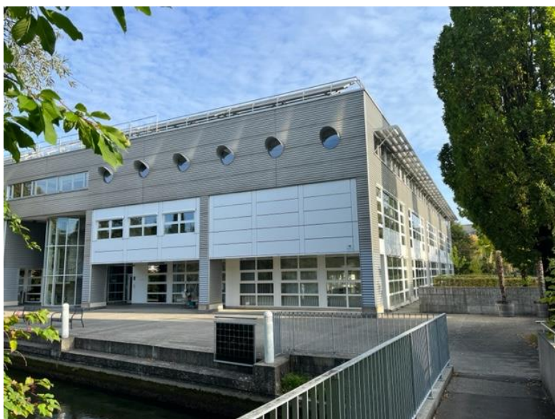
Abbildung 2: Liegenschaft «Tiergarten» am Ilcoweg 1
