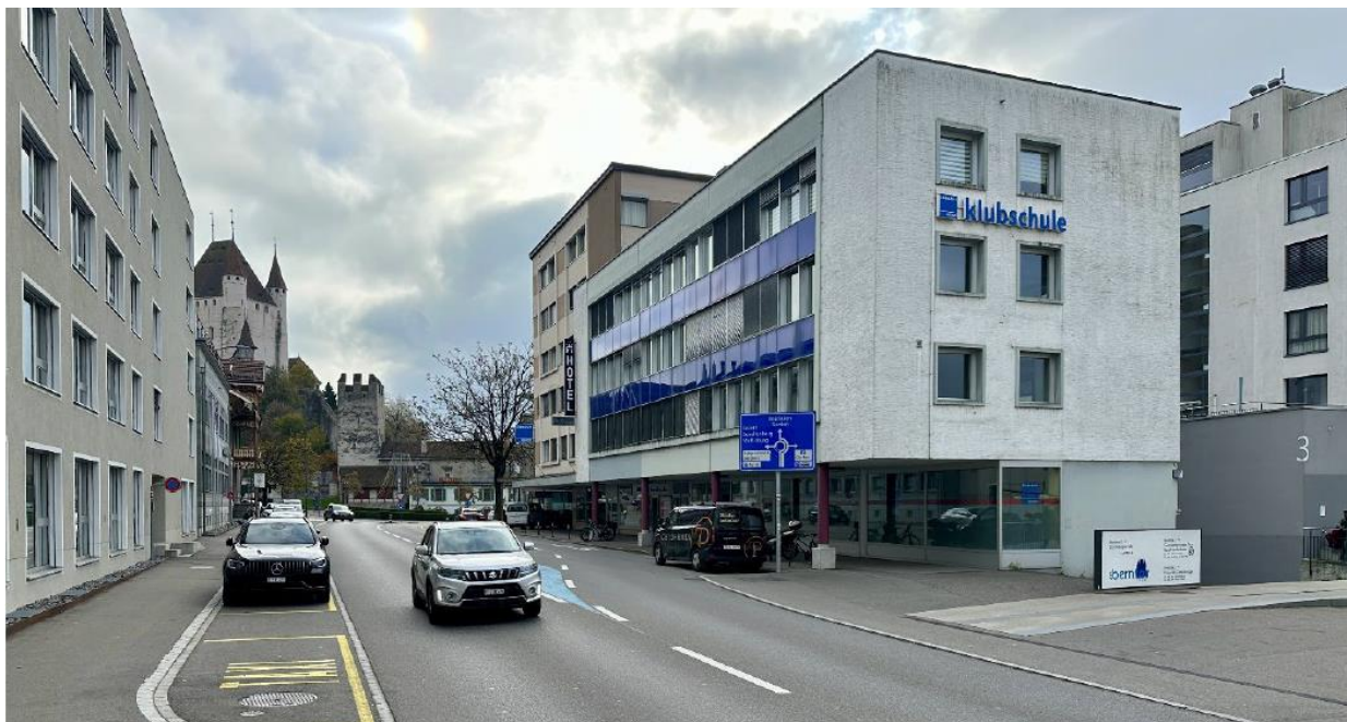
Abb. 2: Aussenansicht des Standorts an der Bernstrasse 1A in Thun
