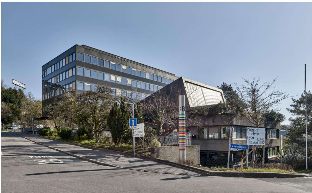
Abbildung 1: Schänzlihalde 31: Unterrichtsgebäude mit Aula
