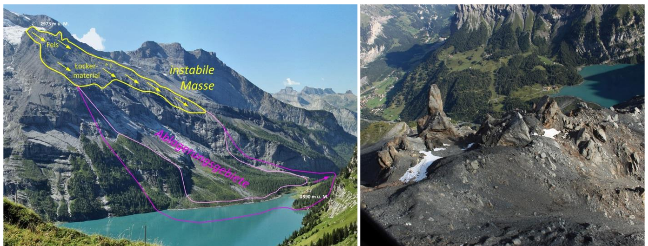
Abbildung 2 Bild links: Ansicht des instabilen Gebiets (gelb) mit Teilen des Wirkungsraums (violett) im Fall von grösseren Abrüchen. Bild rechts: Blick vom obersten Anrissbereich talwärts, links im Bild ist der Pfeiler des namensgebenden «Spitze Steis» zu sehen. Der obere Teil dieses Pfeilers ist am 20. Dezember 2019 abgestürzt (Fotos: Abteilung Naturgefahren).
