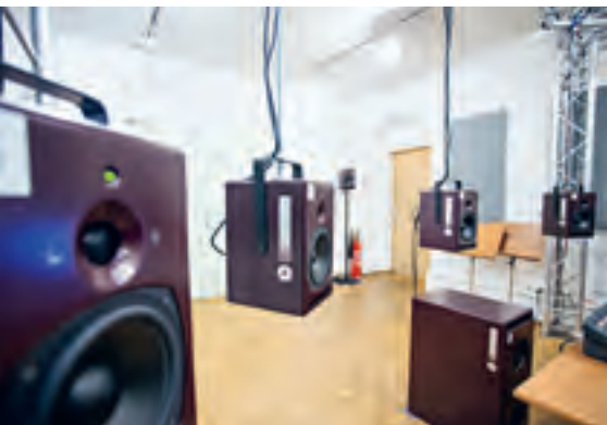
Le Studio Ambisonic de la HEM - Genève est équipé de 26 haut-parleurs disposés de façon sphérique autour d'une régie permettant une prise de son à 360°.
