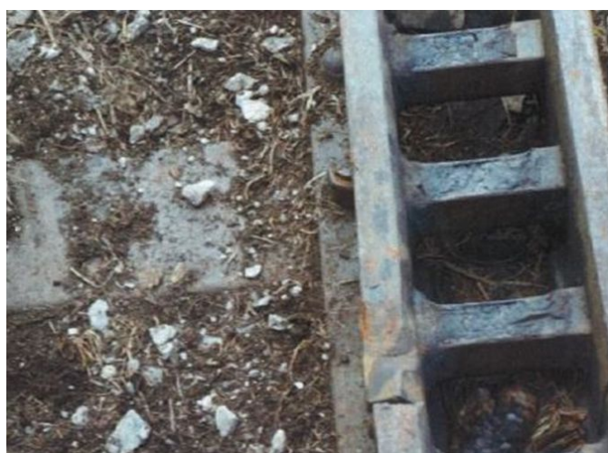
Abbildung 1: Defekte Zahnstangen
