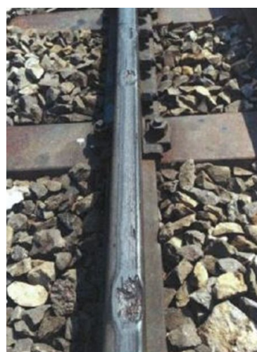
Abbildung 2: Flachstellen auf Schiene
