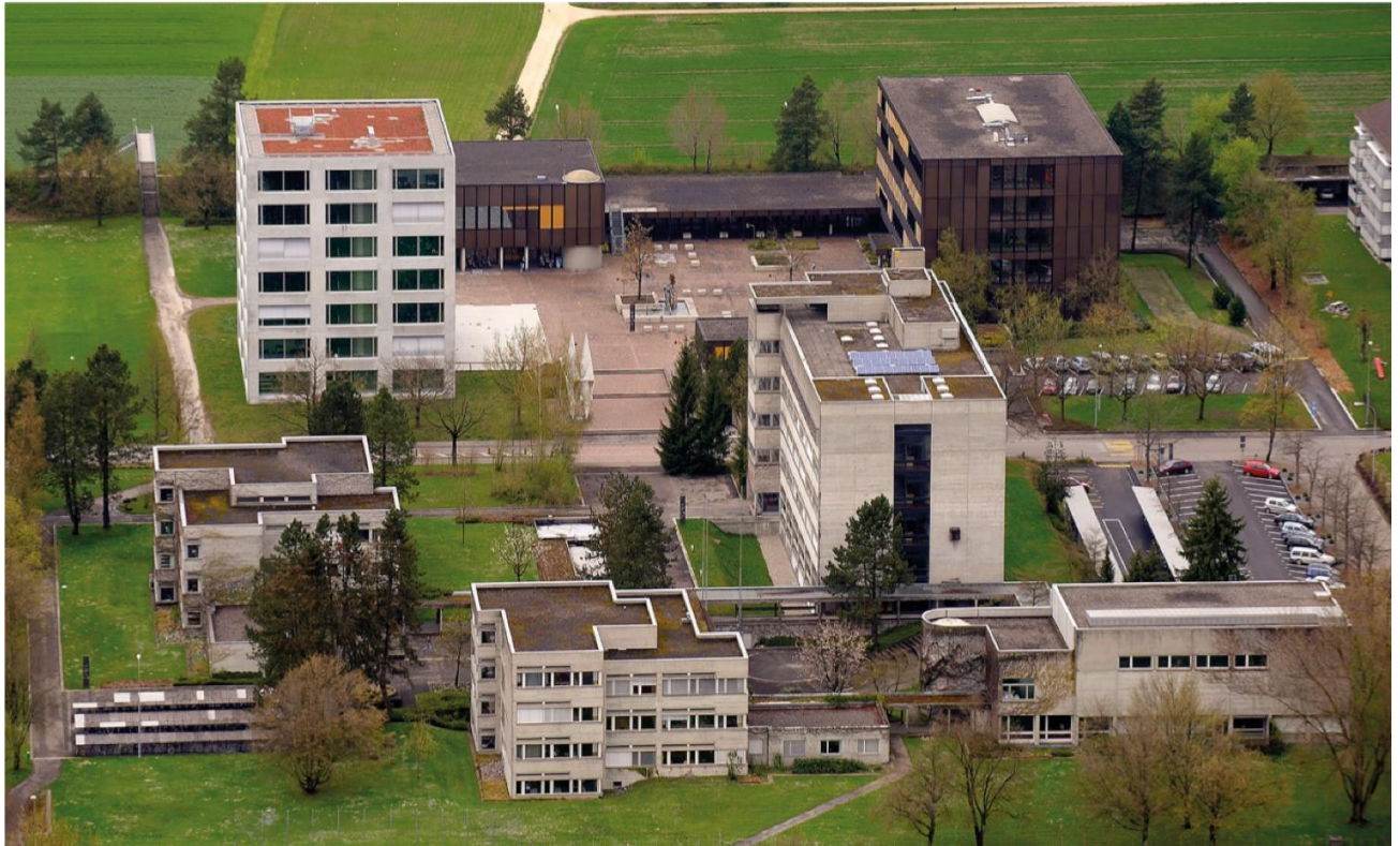
Illustration 1 : Le centre de formation professionnelle de Langenthal, composé du gymnase de Haute-Argovie (en bas de l'image) et de l'école professionnelle (bâtiment brun, en haut de l'image)
