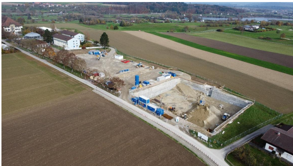
Illustration 1 : Chantier de la salle de sport et du nouveau bâtiment scolaire, état : mi-novembre 2024
