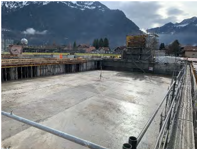
Abbildung 1: abgehobene Bodenplatte
