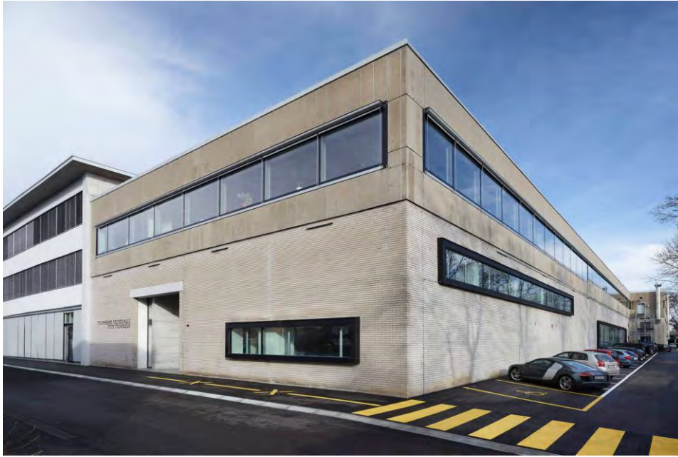
Abb. 2: Aussenansicht des Standorts an der Salzhausstrasse 18 in Biel
