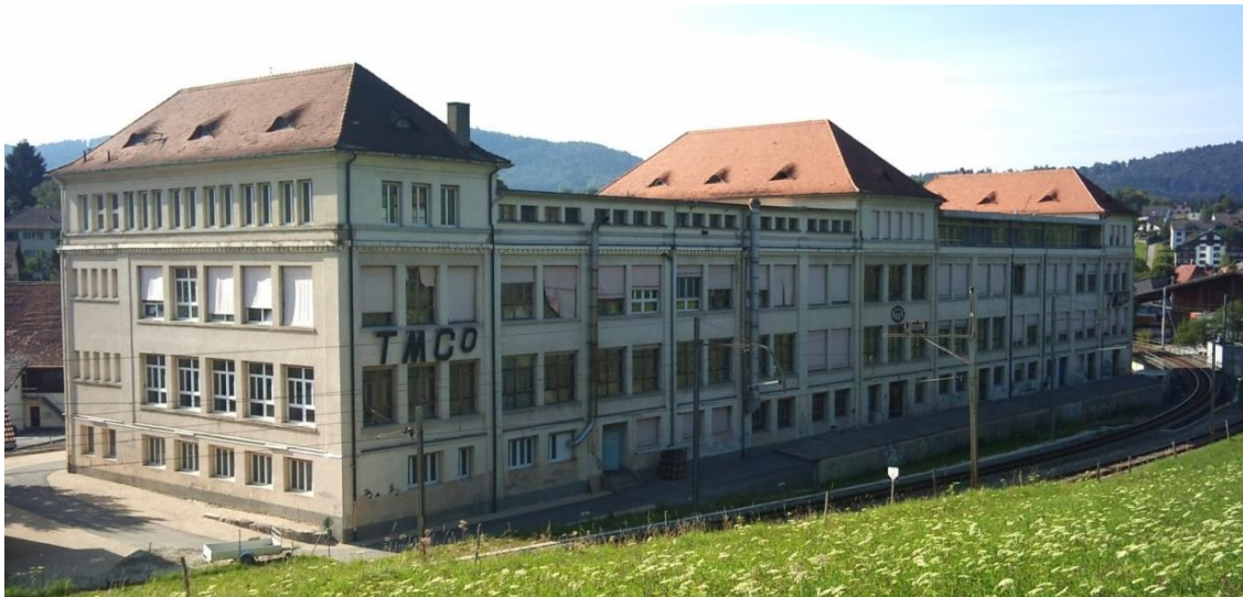
Abb.4: Das Gebäude Tavannes Machines von Ost
