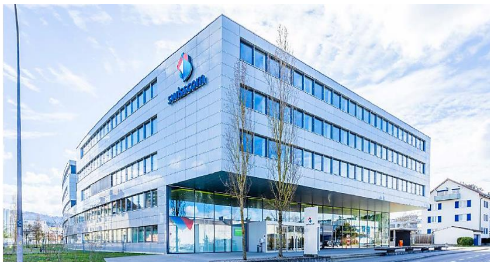
Abb. 3: Der Business-Park Liebefeld an der Waldeggstrasse 51/51a
