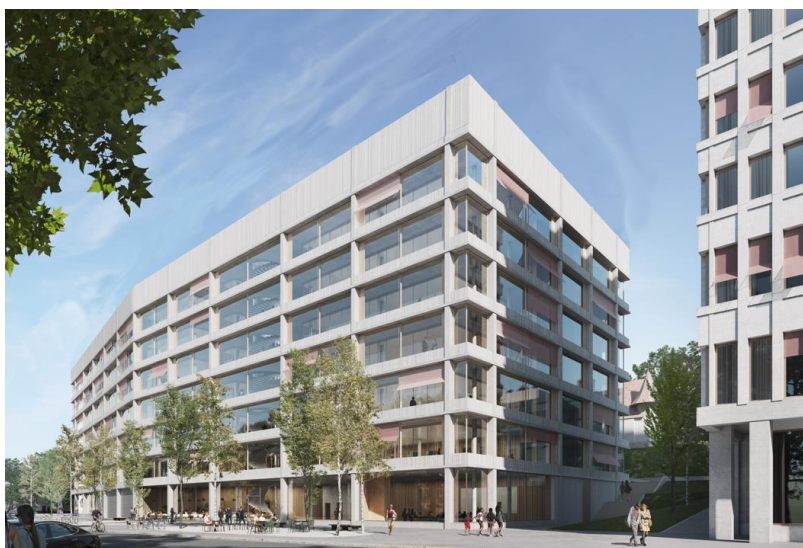
III. 2 : Façade nord avec entrée principale
