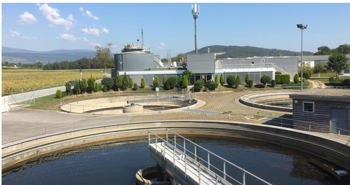
Abbildung 2: Die Abwasserreinigungsanlage in Marin (Herbst 2020)
