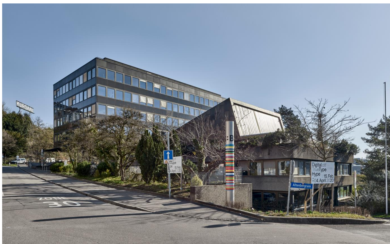
III. 1 : Schänzlihalde 31, bâtiment d'enseignement avec aula
