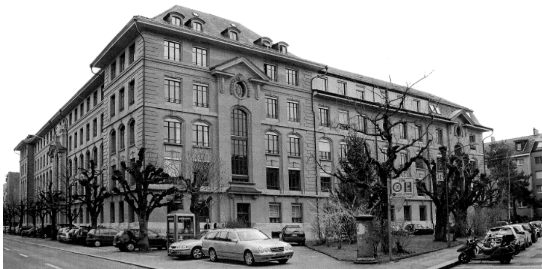
Vue nord-ouest du bâtiment de la Mittelstrasse 43, Länggasse, Berne
