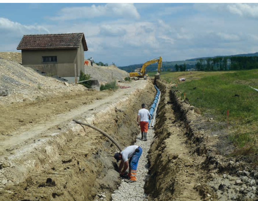
Abb. 8: Müssen wegen einem Bauvorhaben bestehende Leitungen verlegt werden, bietet dies immer wieder Diskussionsstoff, wer für welche Kosten aufzukommen hat. Im Bild: WAGROM-Transportleitung, die wegen der Sanierung des Hagneckkanals an Stelle der bestehenden Leitung neu gebaut werden musste.
