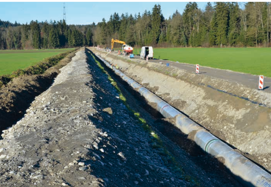
Abb. 2 Durch die Erschliessung neuer Wassergewinnungsorte und den Bau von wenigen Kilometern neuer Leitungen kann die WVRB AG alte Quellableitungen und Transportleitungen von insgesamt 37 Kilometer Länge stilllegen, die in den nächsten Jahren allesamt hätten saniert werden müssen.
